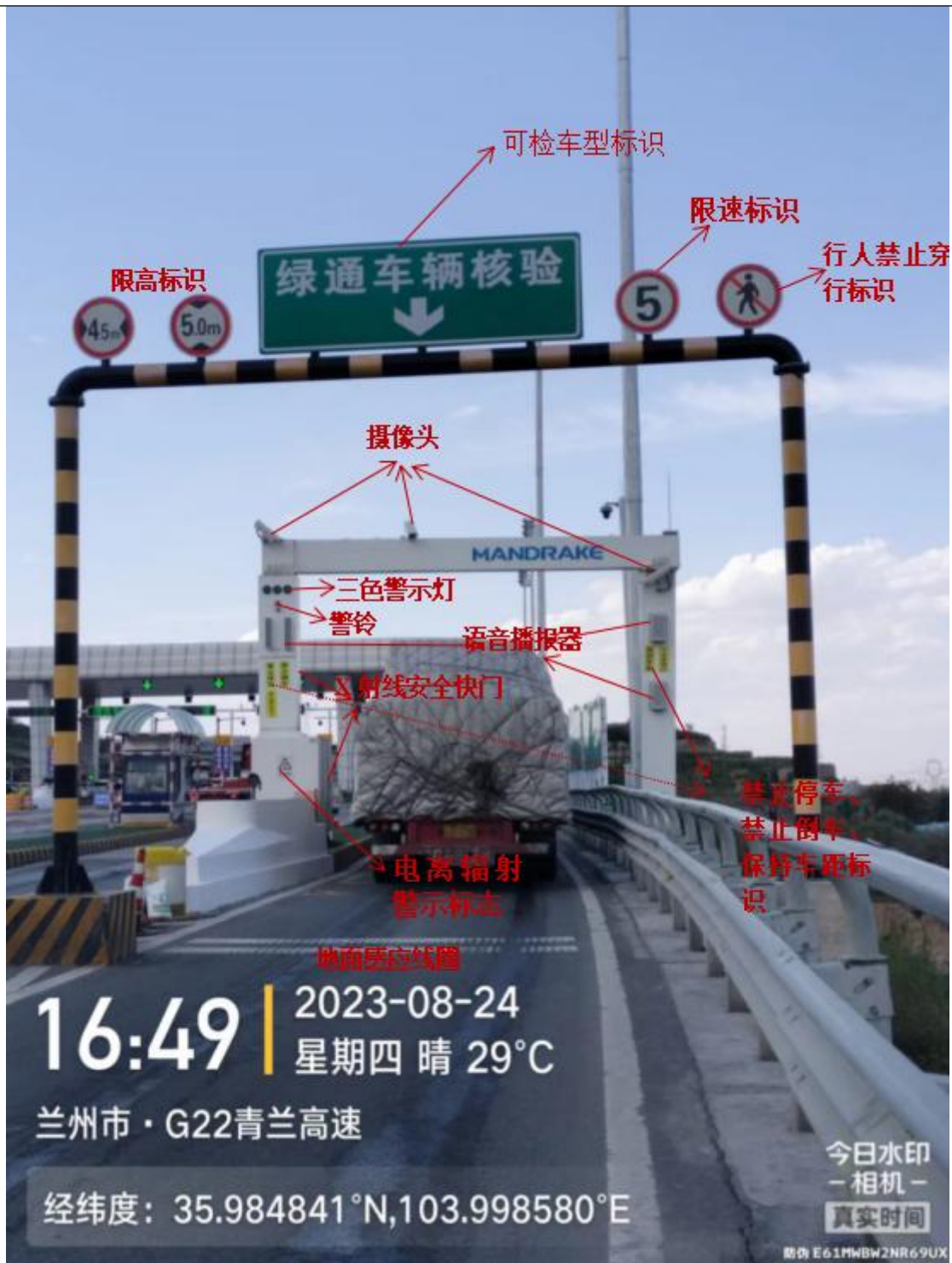
图10-5 现场辐射安全与防护设施图(兰州东为例)
