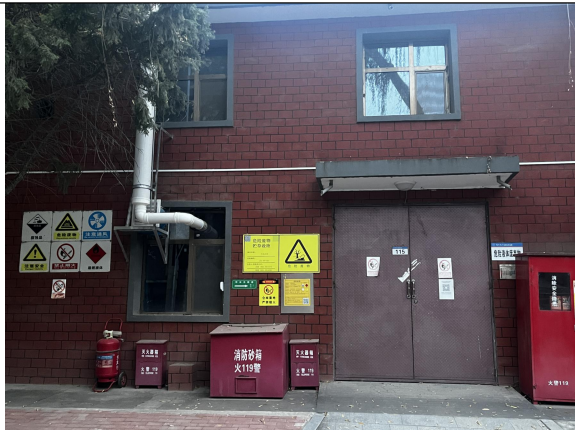
兰州大学危废暂存间
