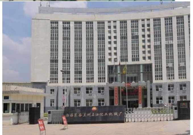
项目南侧渤海装备兰州石油化工机械厂
